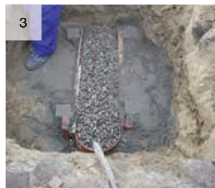
Installazione del drenaggio (letto percolatore o scarico fognario).
