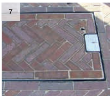
Riempimento della copertura per l'adattamento all'ambiente circostante.
